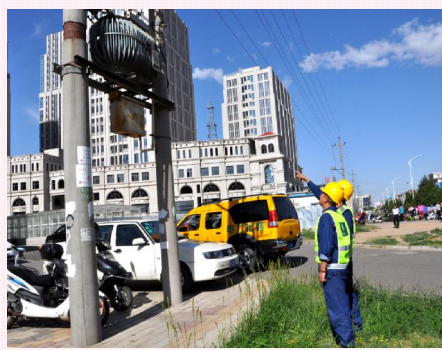
时刻关注供电情况 张芳摄
