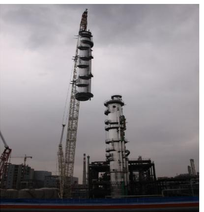
该H2S浓缩塔是净化装置核心设备,H2S浓缩塔是将富甲酮中的H2S气体进行浓缩,将CO2解吸的关键设备,高96.2米,直径4.7米,设备重505吨,采用1250吨履带吊吊。
