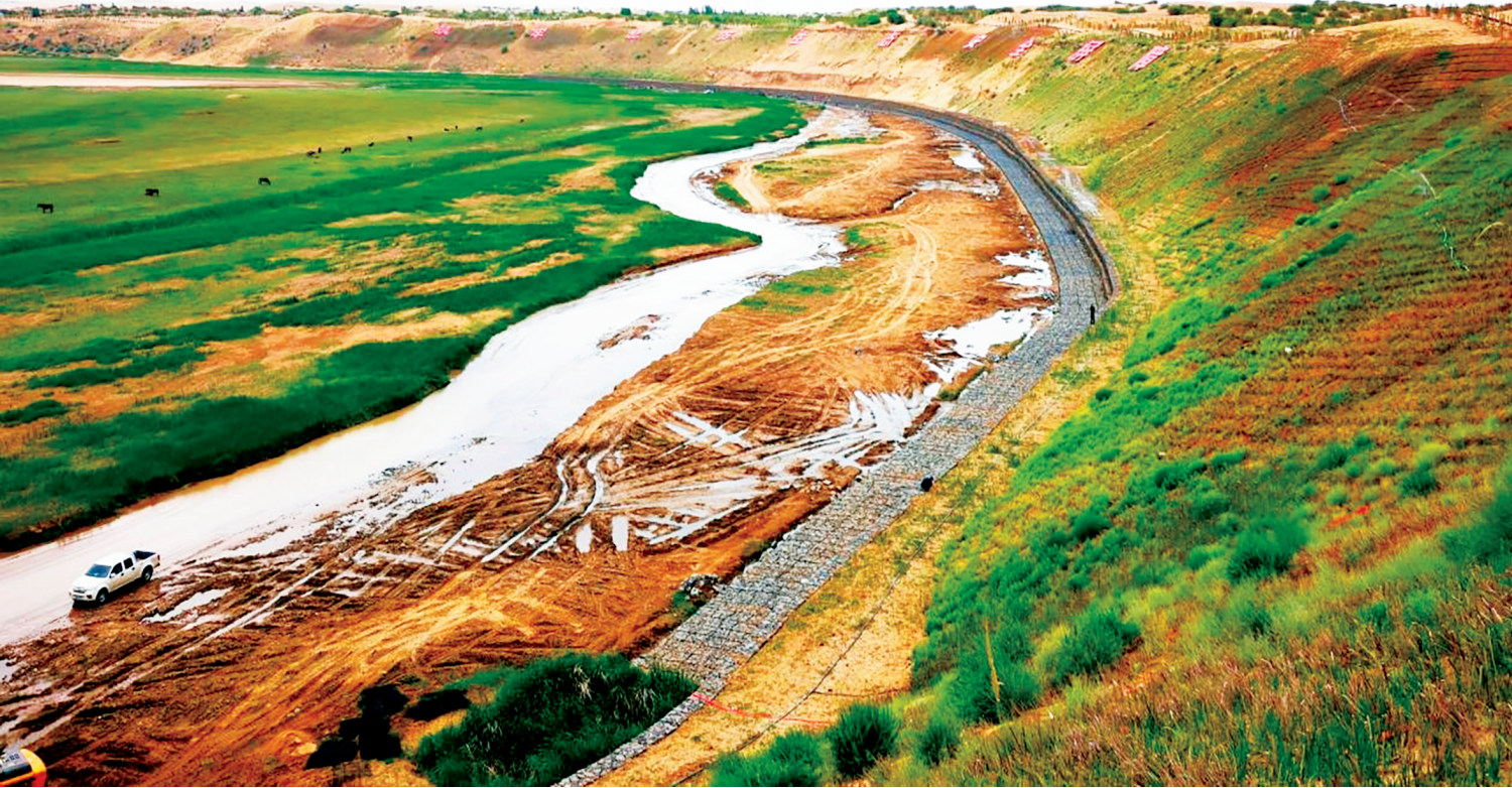
▶达拉特旗西柳沟龙头拐生态清洁小流域水土保持综合治理工程护岸工程。
