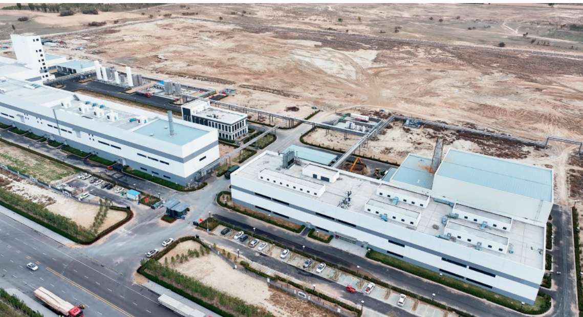
内蒙古亨通光学材料有限公司一期年产600吨光纤预制棒、内蒙古亨芯石英有限公司一期年产100吨高纯合成石英项目航拍图。 摄影:张奥卓
