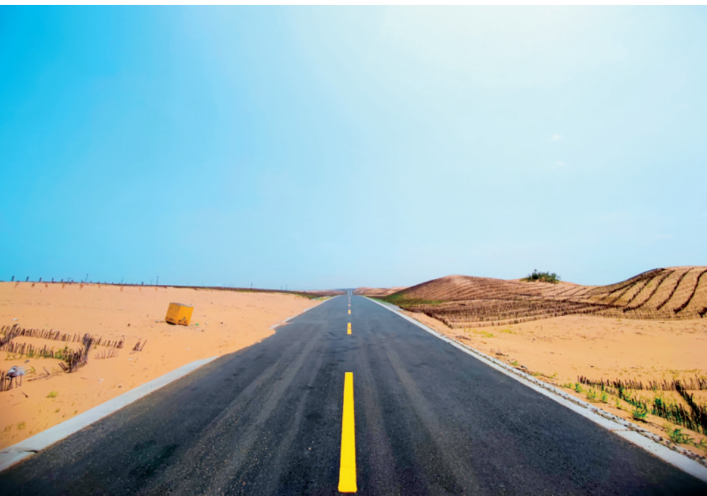
▲鄂尔多斯市达拉特旗巴音至蒲圪卜公路两侧,排列整齐的草方格沙障锁住黄沙。该项目按照三级公路技术标准建设,公路两侧沙障栽植面积共计1270亩,栽植各类苗木66万株,撒播草种4000公斤,有效遏制风沙侵袭、固定流动沙丘、防止沙漠扩张,是达拉特旗“以路治沙”治理模式的有效探索。
