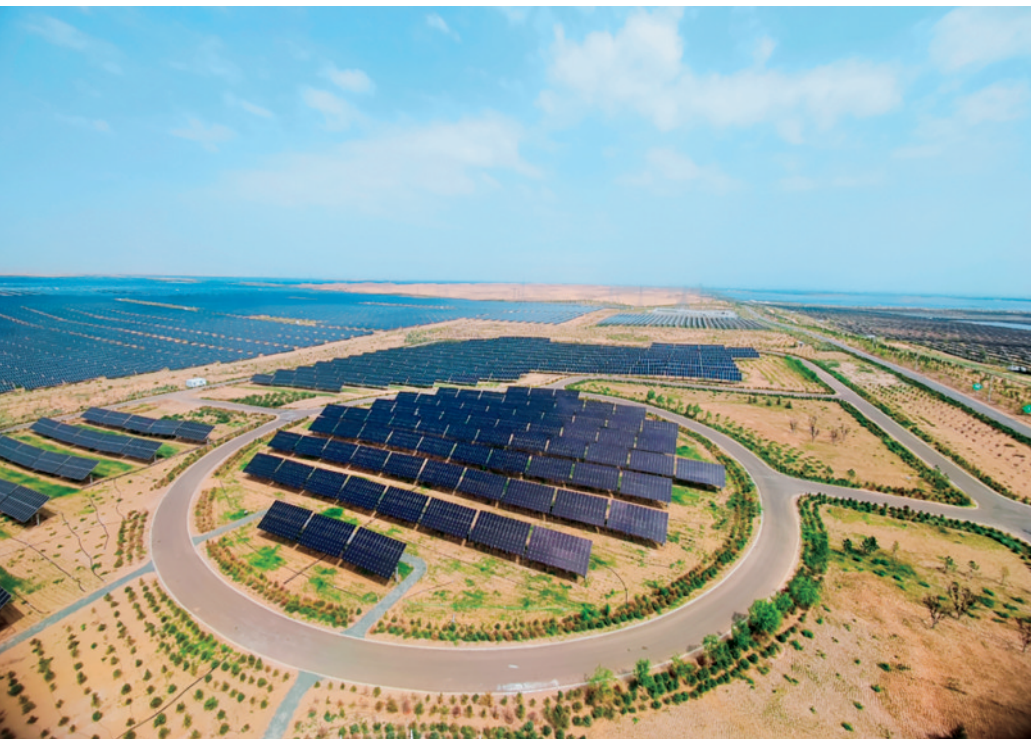
▲鄂尔多斯市达拉特旗光伏基地采用“板上发电、板下种植、板间修复”模式,在输送清洁能源的同时,有效改善沙漠生态环境。
